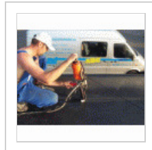
ABG®-Extrusions-schweißung
