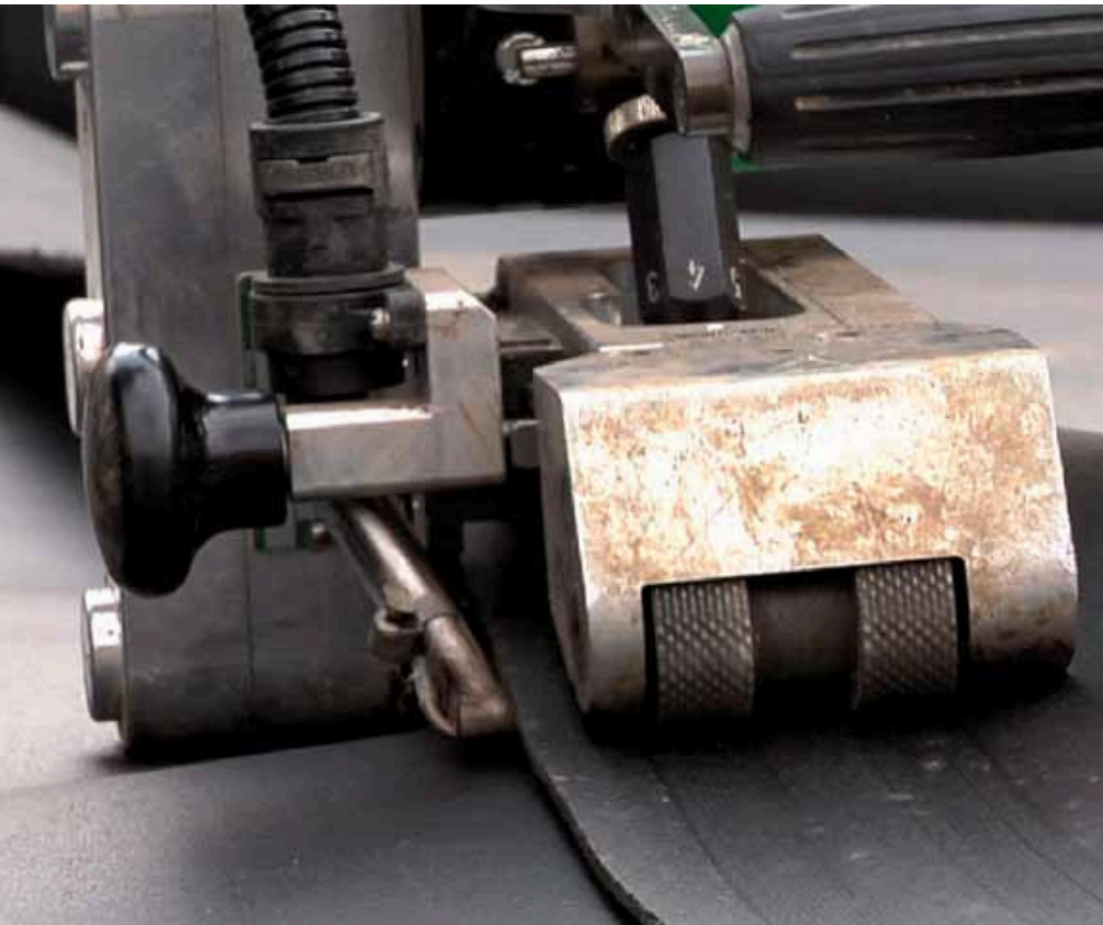
Entscheidend: die thermische Verschweißung.
