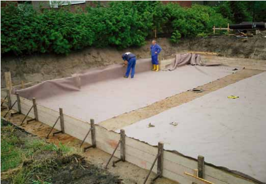
Die Abdichtung der Sohle: Zuerst wird in der trockenen Baugrube das ABG-Schutzfließ ausgelegt.
