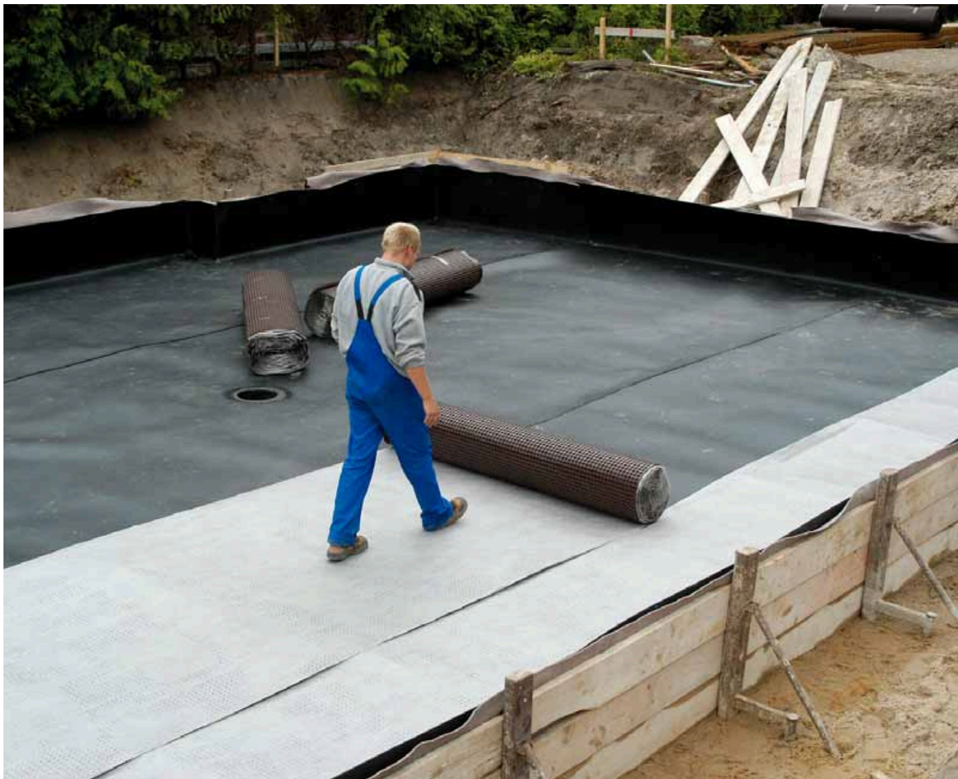
Dann folgt das Auslegen der ABG-Atmungsfixbahn. Entsprechend wird bei der Wandabdichtung verfahren. | Fotos: ABG
