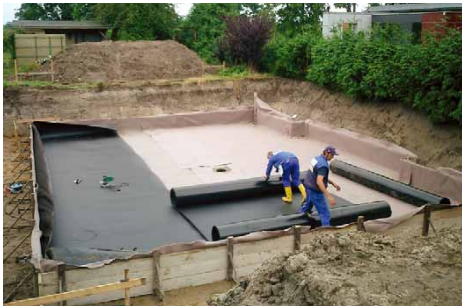
Darauf folgt die ABG-Dichtungsbahn.
