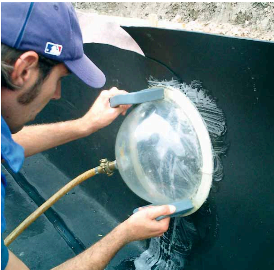
Die Extrusionsnähte werden mit einer Unterdruck-Saugglocke auf Dichtheit überprüft.
